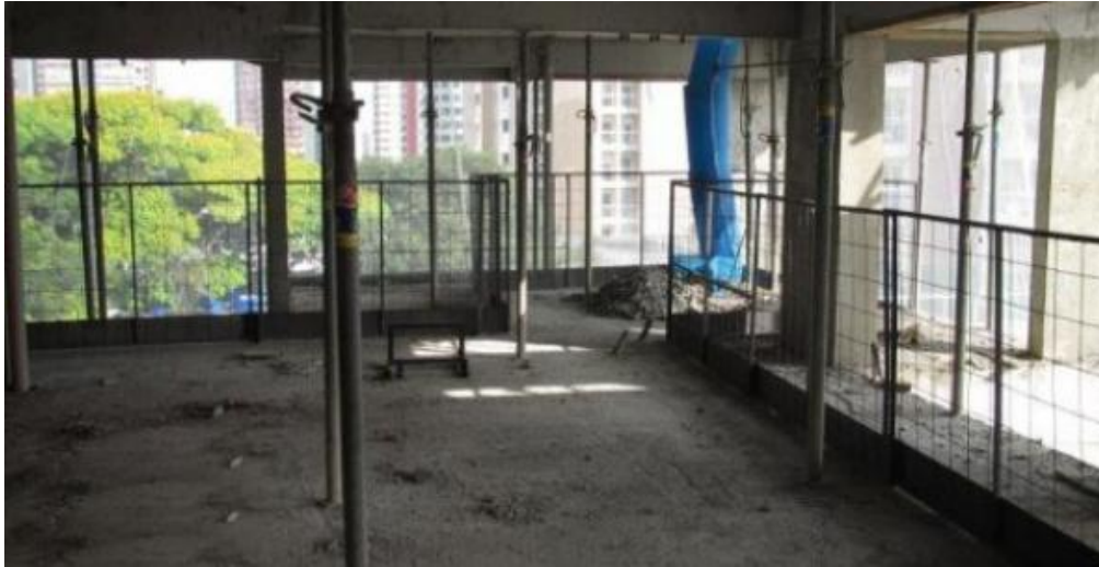
Imagem 2: Proteção Periférica Recuada
