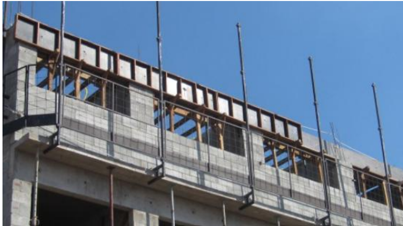
Imagem 4: Proteção Periférica Simultânea
