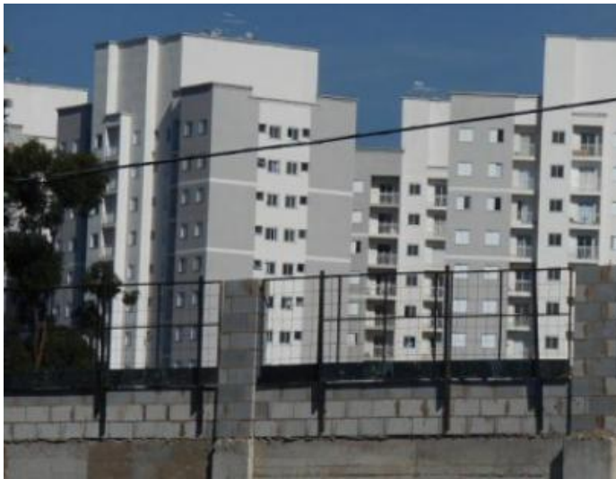
Figura 1 - Proteção Periférica na Face da Vida
