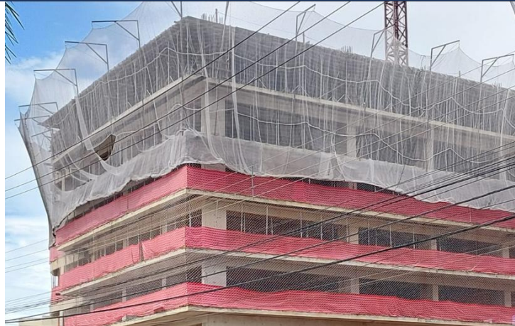
Figura 6 - Telas tapume - Proteção de guarda corpo
