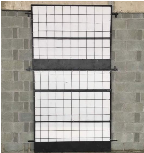
Figura 5 – Proteção da porta e poço do elevador
