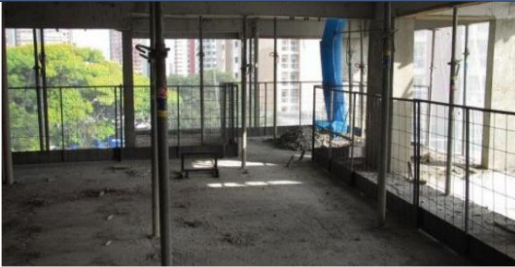
Figura 2 - Proteção Periférica Recuada
