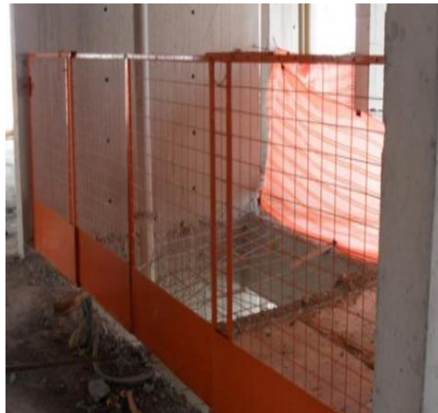
Figura 5 – Proteção da porta e poço do elevador
