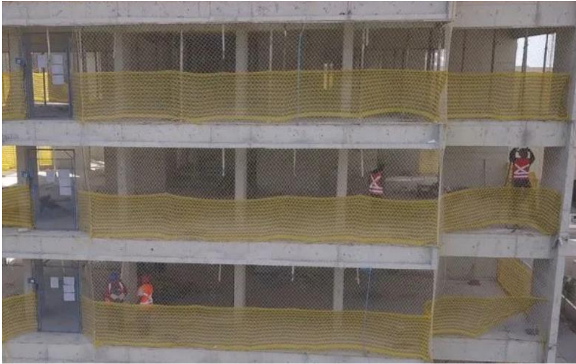
Imagem 1: Tela de Segurança para Fachada Anti-Queda (visão externa)
