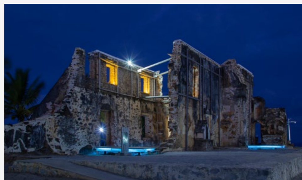
Ruínas do Mosteiro de São Bento
